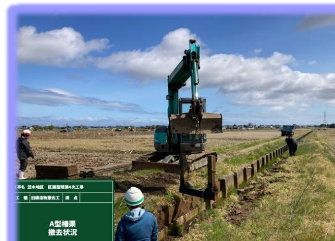
旧構造物撤去【Co製品】
