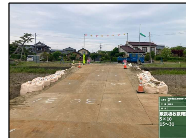
仮設ヤード施工完了
