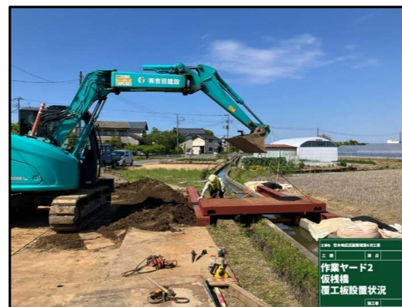
仮設ヤード施工状況
