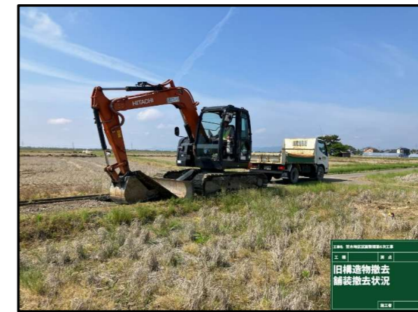
既設舗装撤去状況
