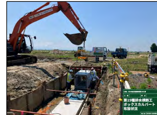
ボックスカルバート設置状況
