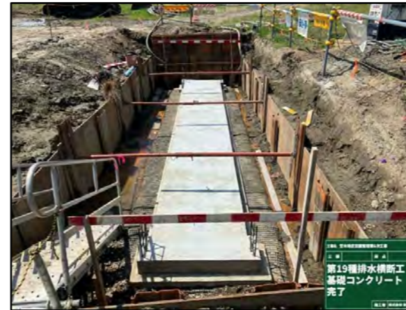
基礎コンクリート打設完了
