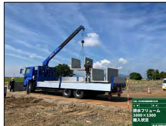
コンクリート二次製品荷卸し状況
