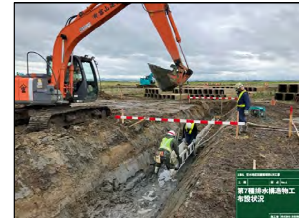
排水フリーユーム布設状況
